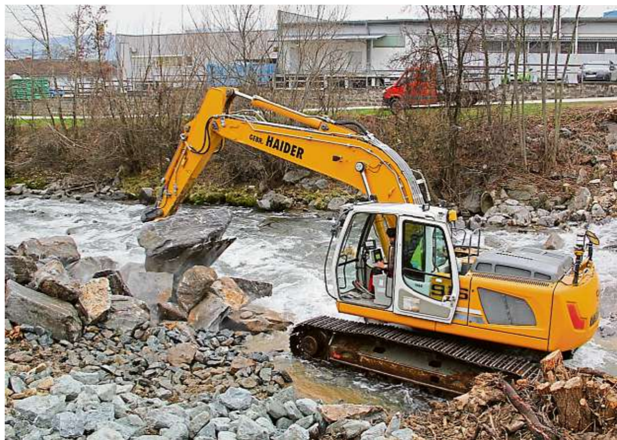
Ein mittels GPS gesteuerter Bagger kommt in der Lavant ebenfalls zum Einsatz SCHMERLAIB (4), PRIVAT
