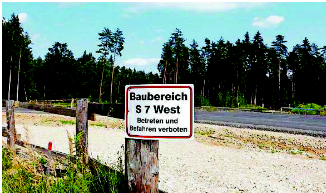
Rund 700 Millionen Euro werden von der Asfinag in die S 7 Schnellstraße investiert
