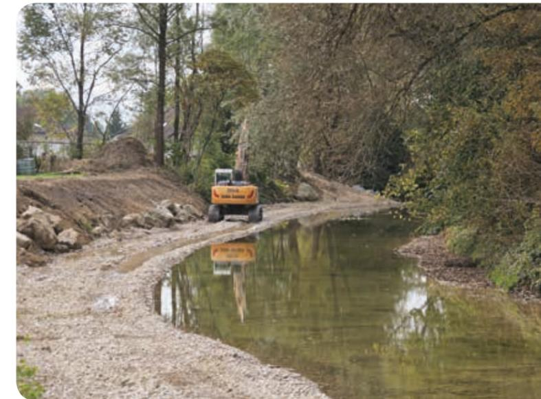
Abschließend werden die Dammböschungen humusiert, teils einer natürlichen Sukzession (auf natürlichen Faktoren beruhendem Nachwuchs) überlassen, teils werden Weidenfaschinen eingebaut, südseitige Dammböschungen werden überwiegend als Magerwiese ausgeführt. Wo möglich, werden nach der Dammerstellung wieder heimische standortgerechte Laubgehölze gepflanzt. Die Rondungsarbeiten wurden bereits überwiegend abgeschlossen, derzeit ist die Baustraße im Bachbett in Arbeit.
